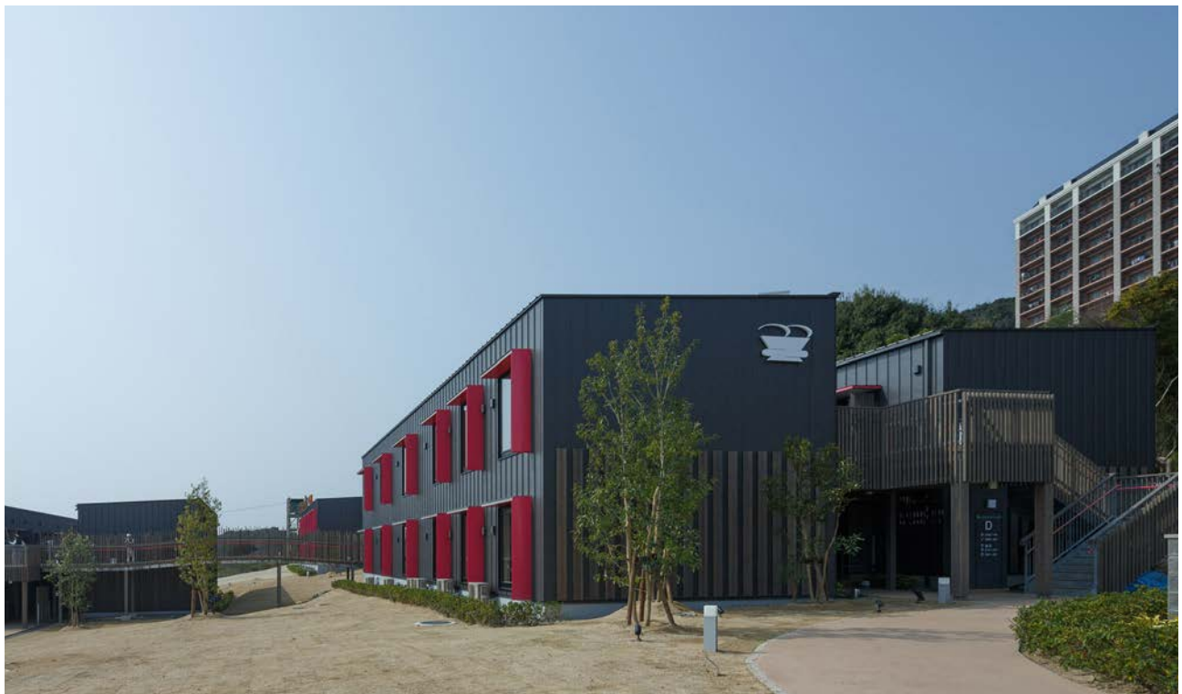
D 棟外観、奥に E 棟と F 棟が見える
