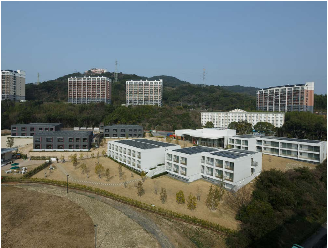
左手の黒い外装の建物3棟が CLT 工法による今回の計画 D、E、F、棟
