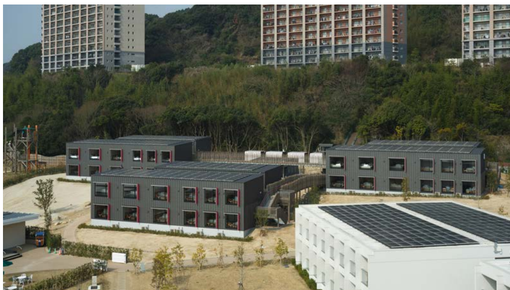
竣工した建物の外観
