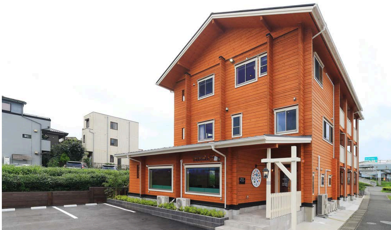
東側カフェエントランス側の外観
