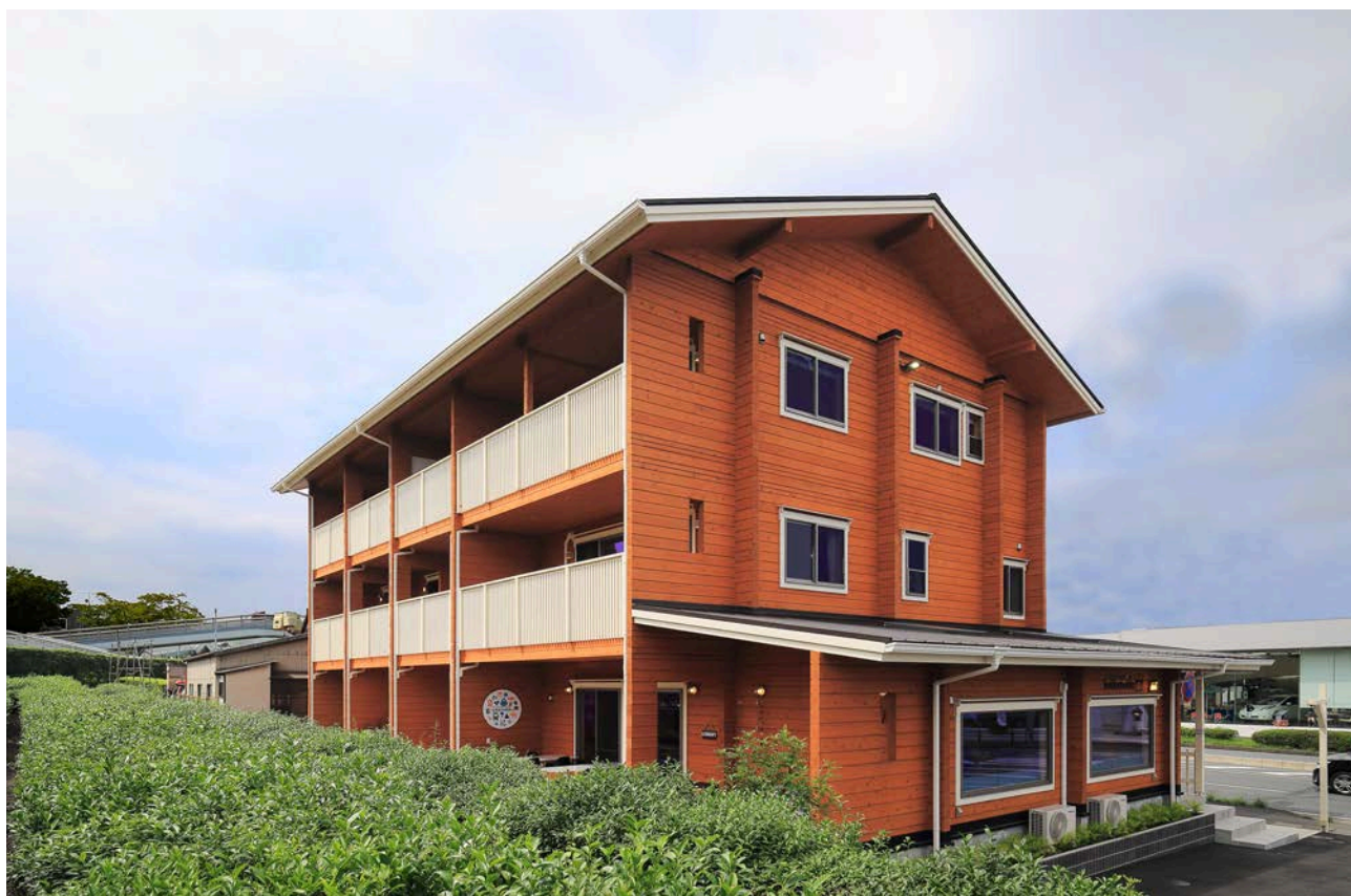
総3階建てのログハウスとして建てられた南側外観
