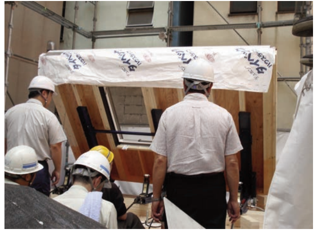
建て起こし工法の施工の様子
