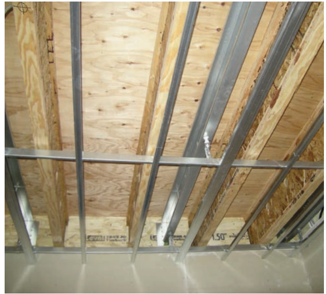
耐火構造床にジョイストを採用
