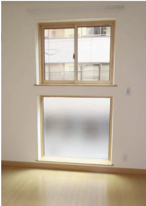
アルミクラッド樹脂サッシとLow-Eペアガラスの採用で高い断熱性
