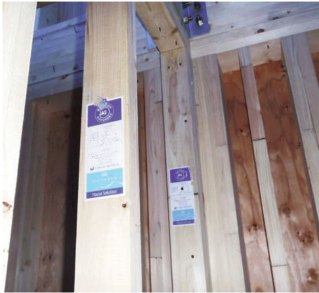
国産材による縦枠を採用
