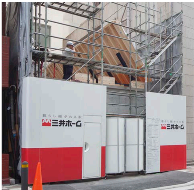
2階外壁の建て起こし中の外観
