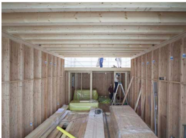
壁パネル・床パネルの設置完了状況
