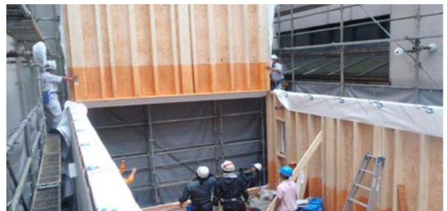
外壁パネルの設置の様子
