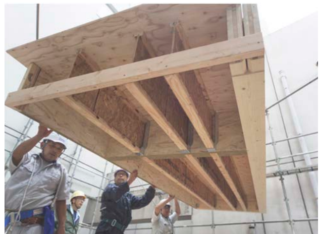
床パネルの建て込み風景
