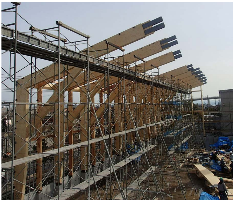
フレームの建方の様子
