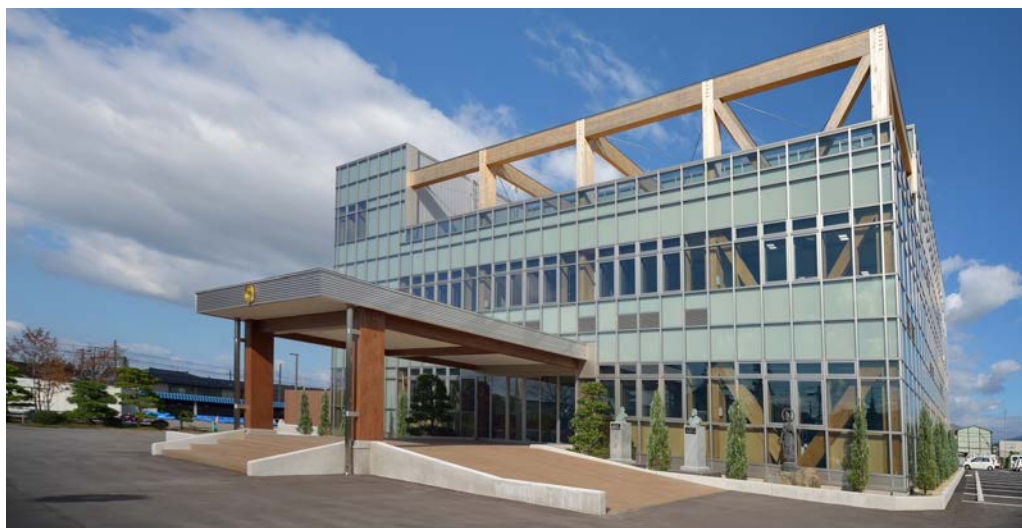
外部からも柱、梁、ブレースの木組み構造が見える親しみやすい外観
