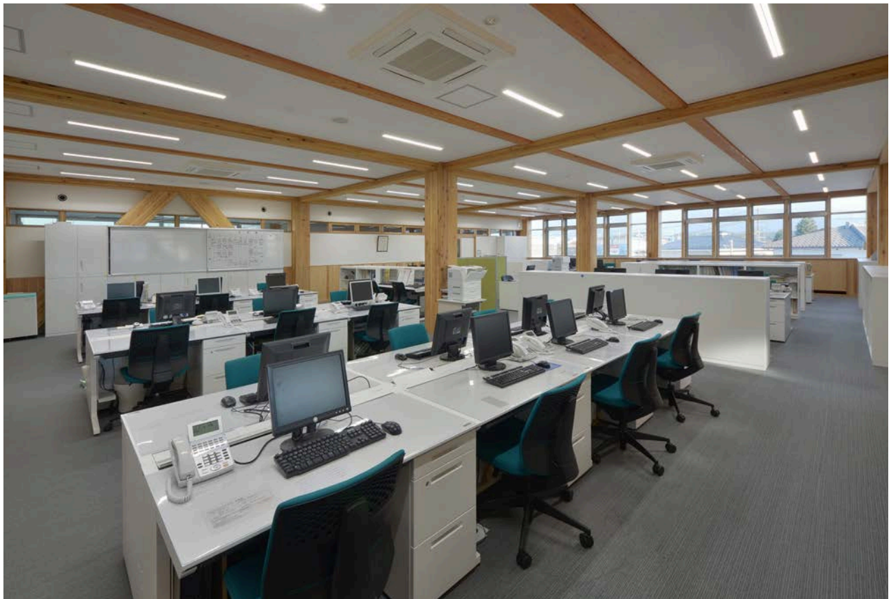
事務室空間も木の柱・梁・ブレースがあらわしに
