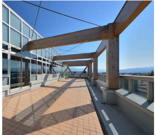
3階バルコニーは木組みの構造が外部にも露出
