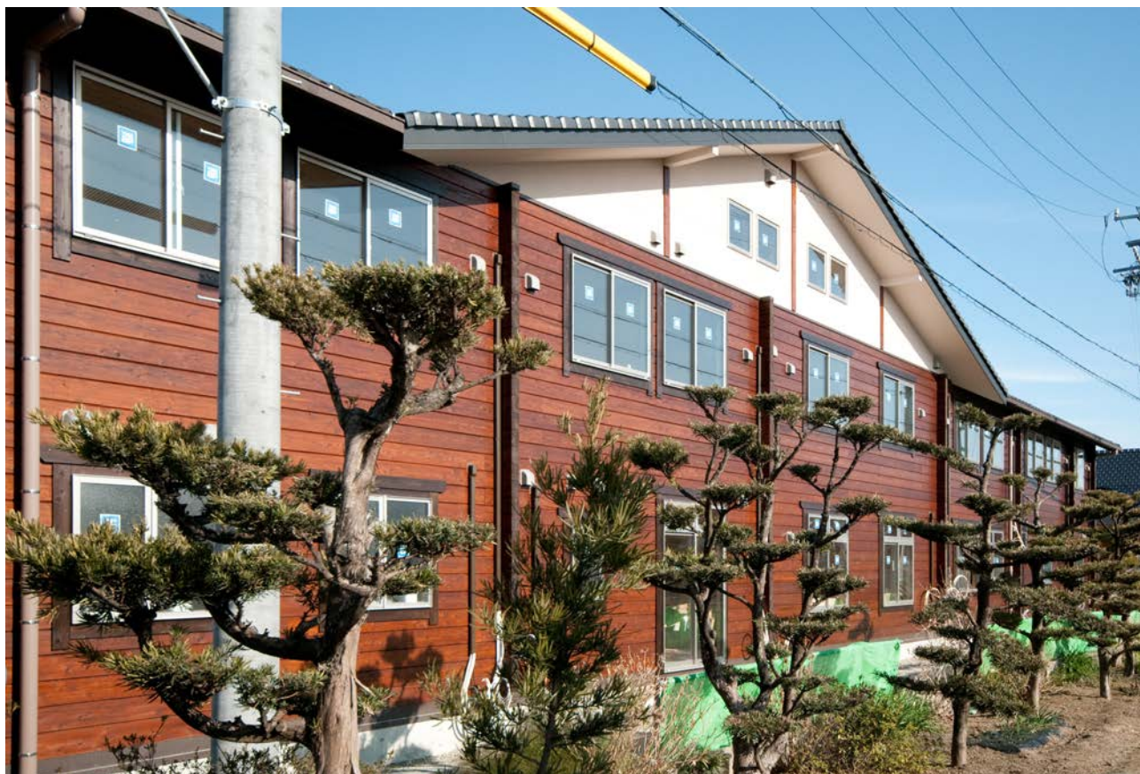
高齢者賃貸住宅、デイサービスなどがある丸太組構法の棟の東側外観
