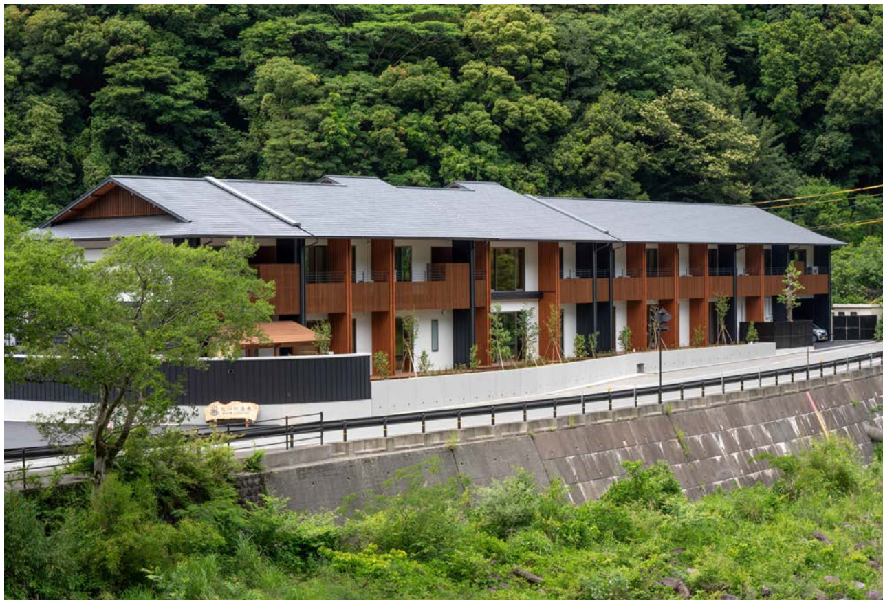
南側からの全景
