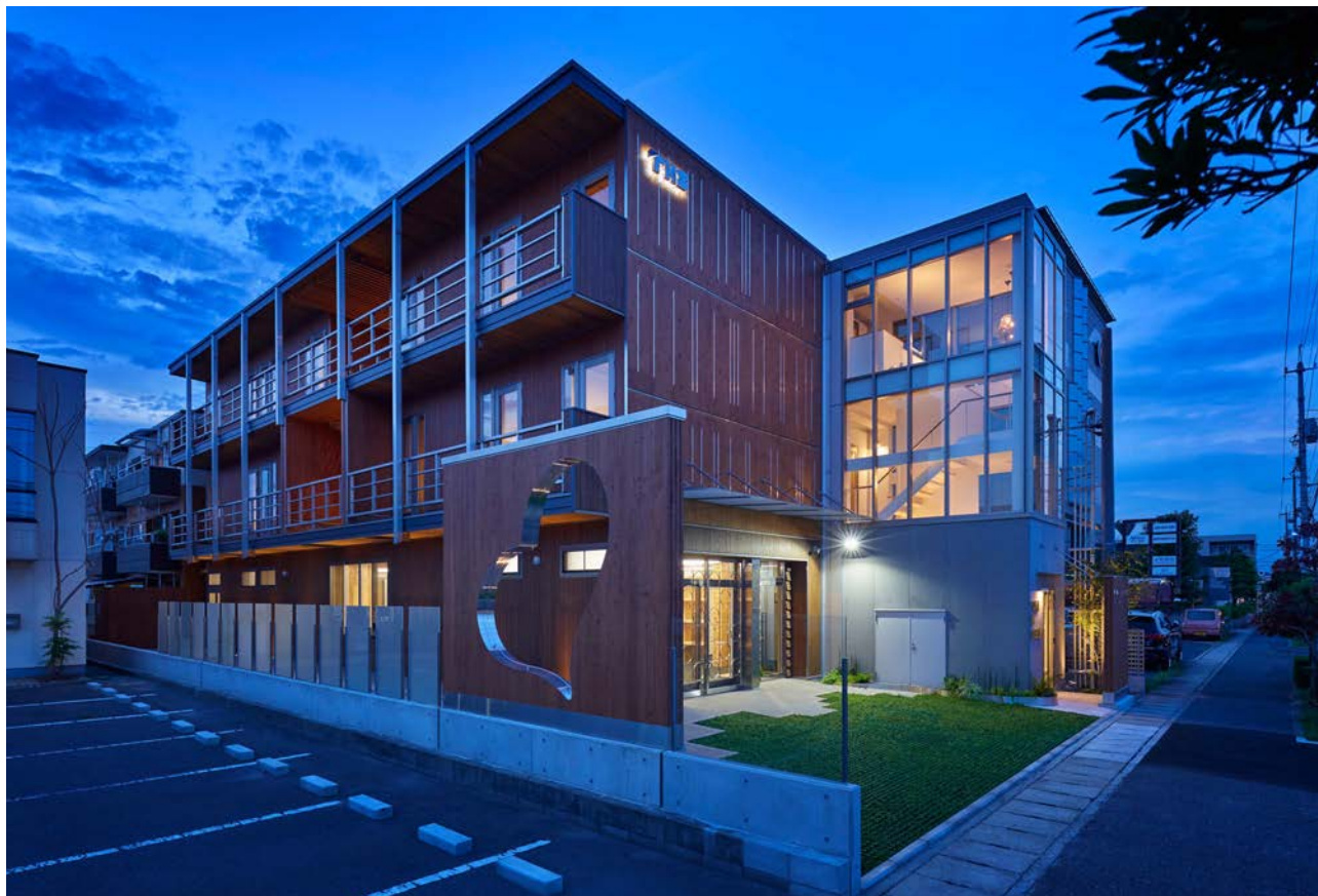
東側からの外観（夕景）
