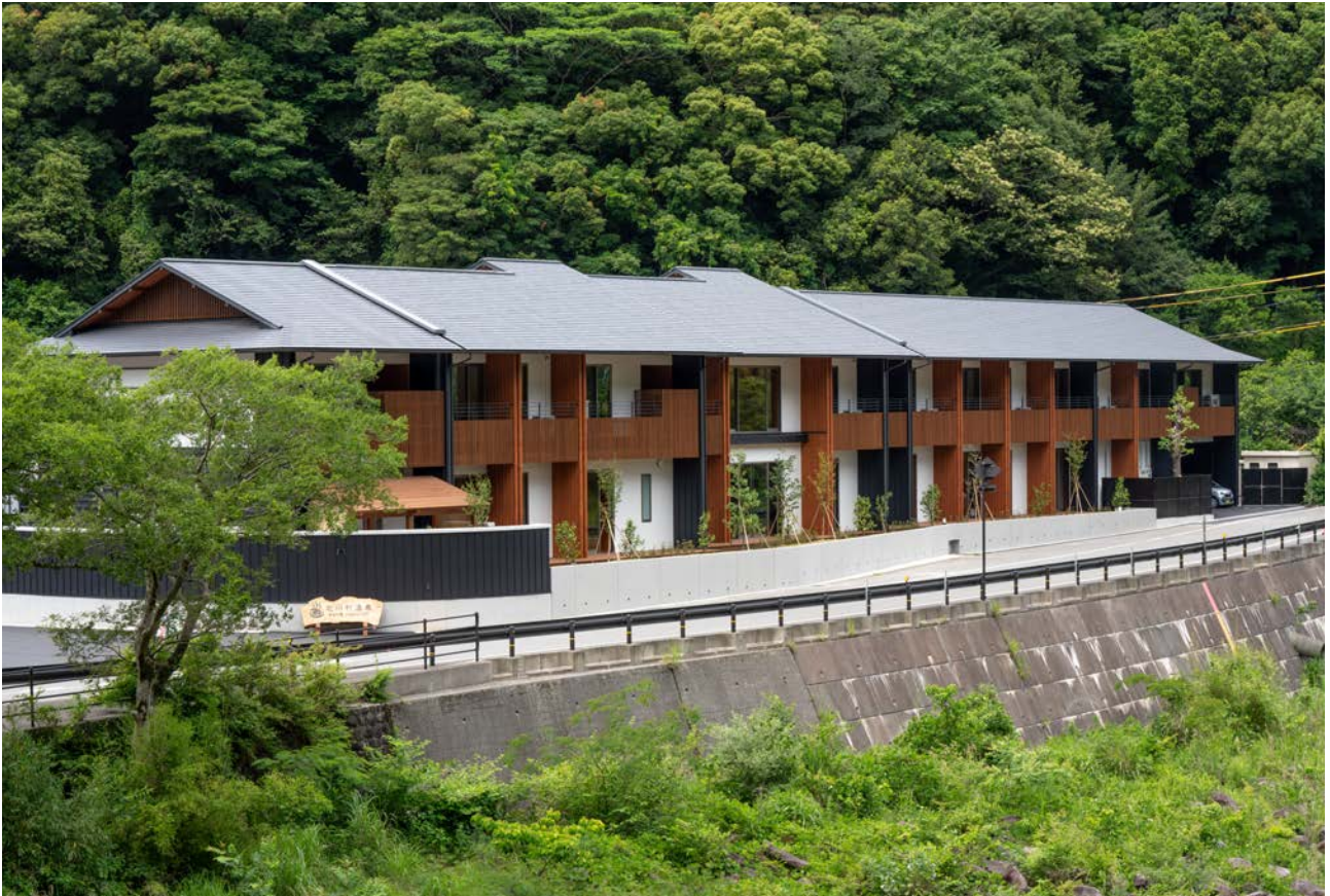
南側からの全景
