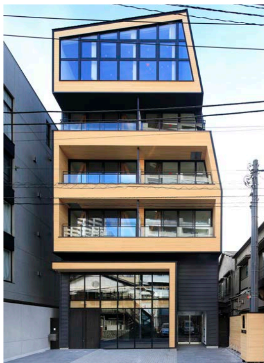
北側正面外観
