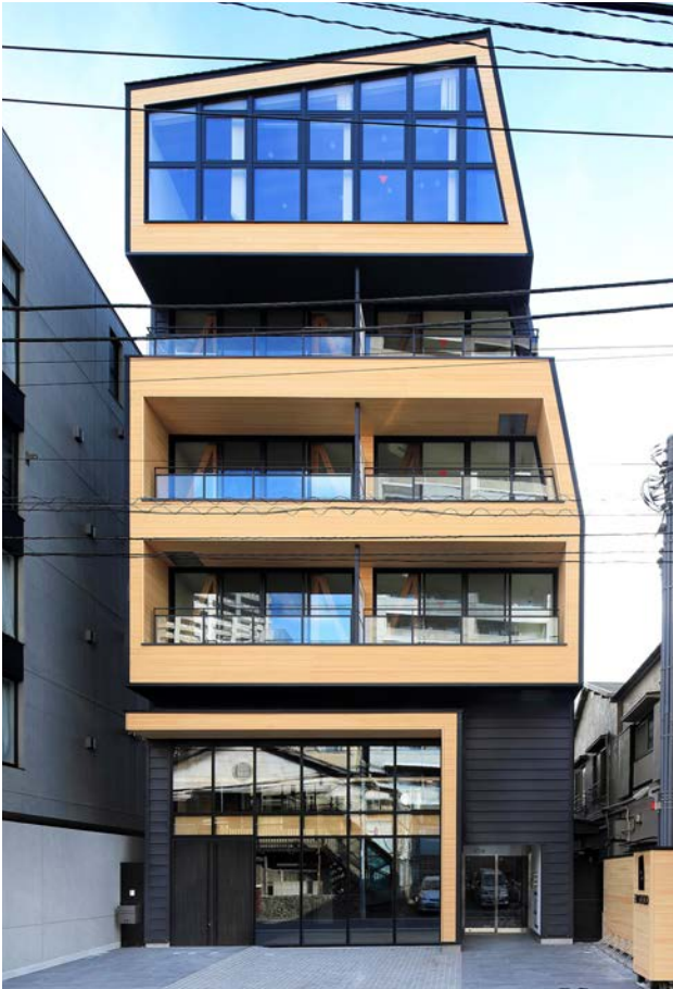
北側正面外観
