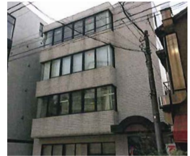
解体前の既存RC造ビル
