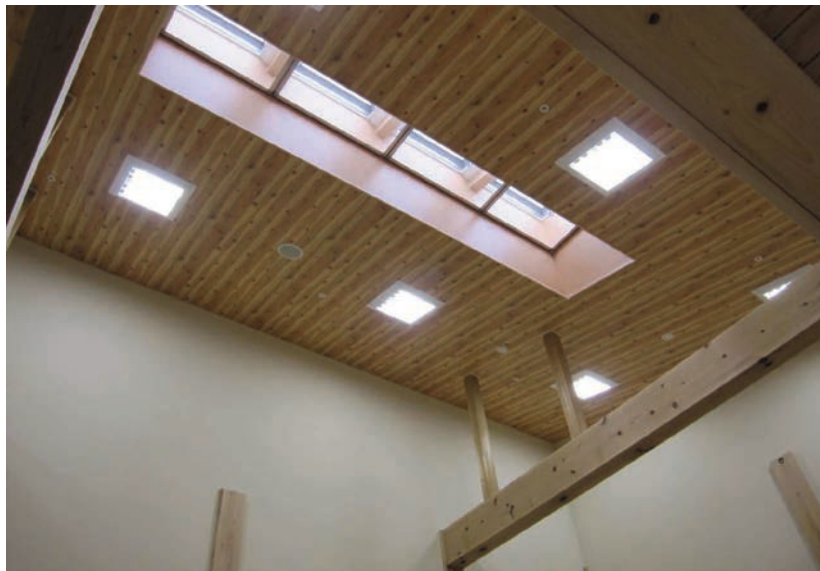
中央ホールのトップライト
