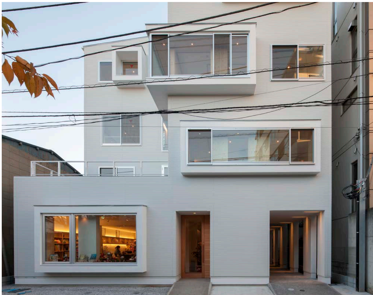
北側外観を正面より見る
