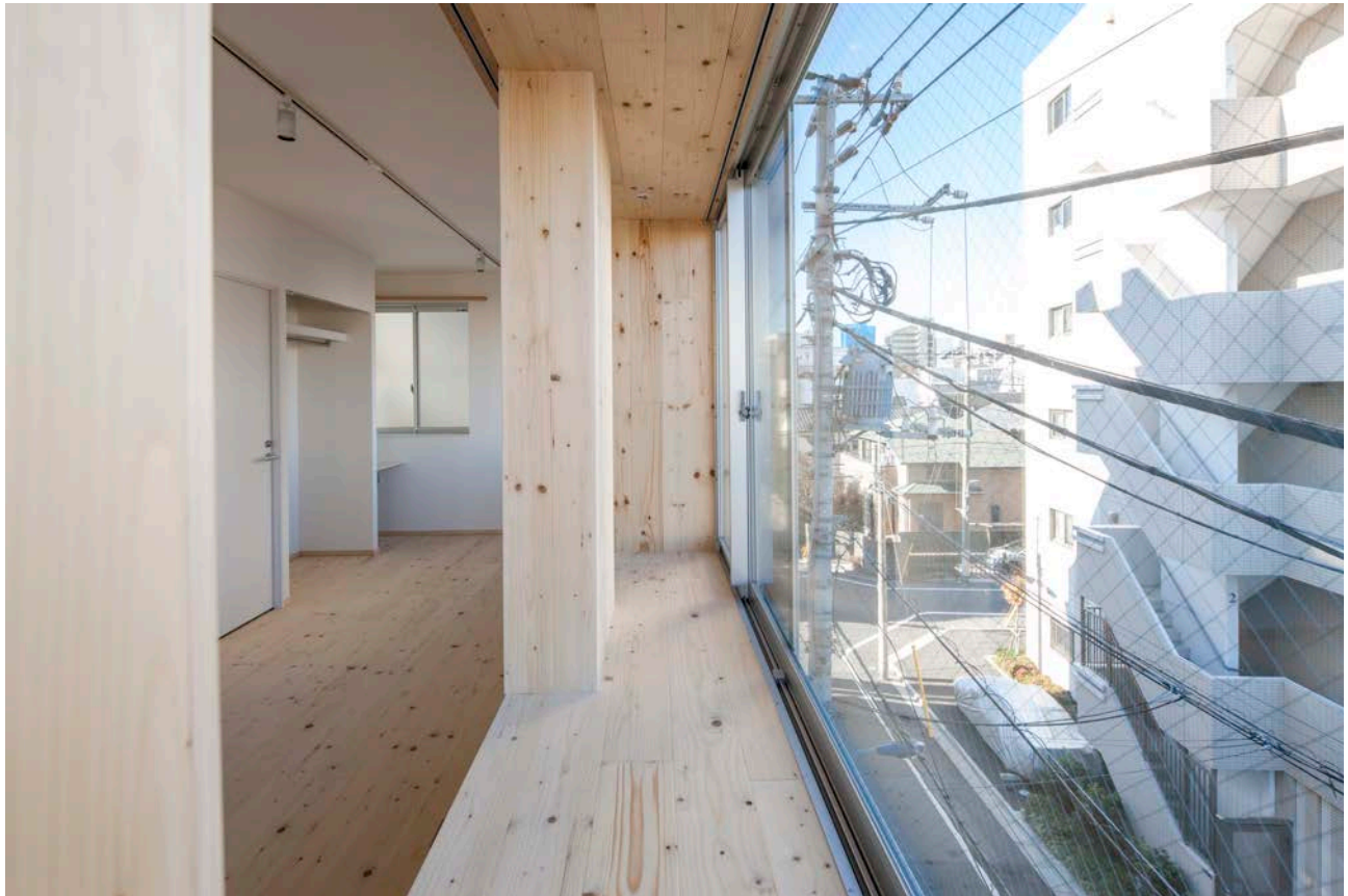
パネルの主な材料であるトドマツを耐火被覆した壁パネルの上に貼り木質化した
