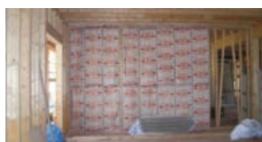
枠組み壁工法の戸境壁下地組
