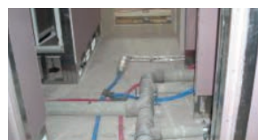
二重床設置前の戸内配管
