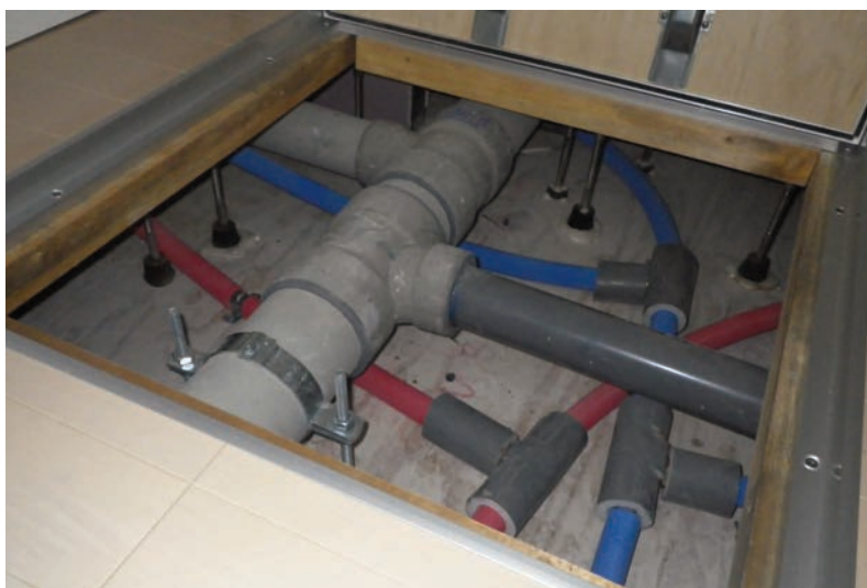
床下配管の状況
