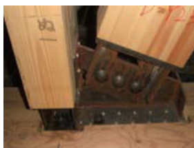
斜め材接合部
