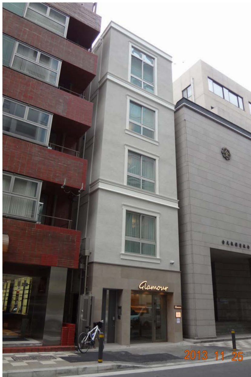
枠組み壁工法で作られた木造5階建ての外観
