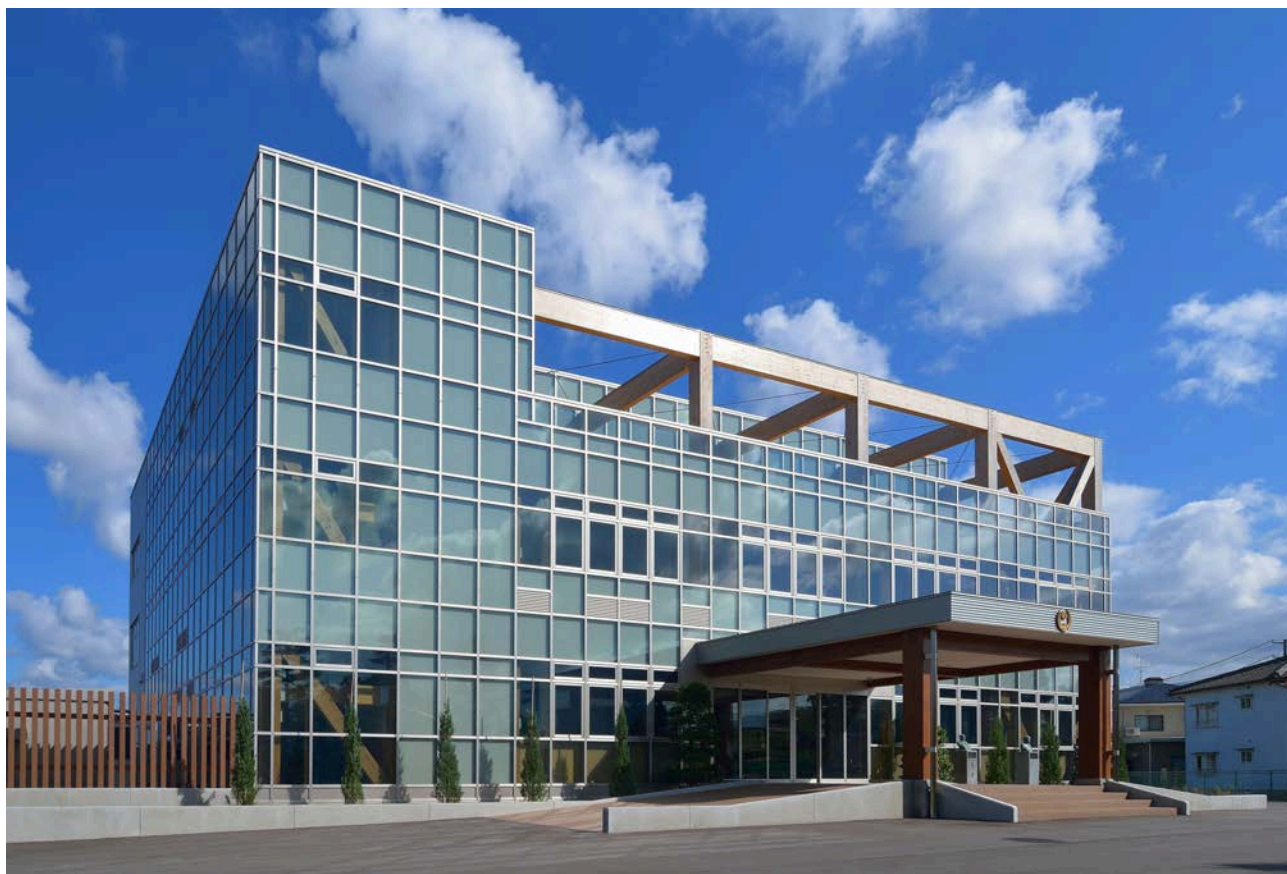
ガラスカーテンウォールを透して木組みの構造が見える外観
