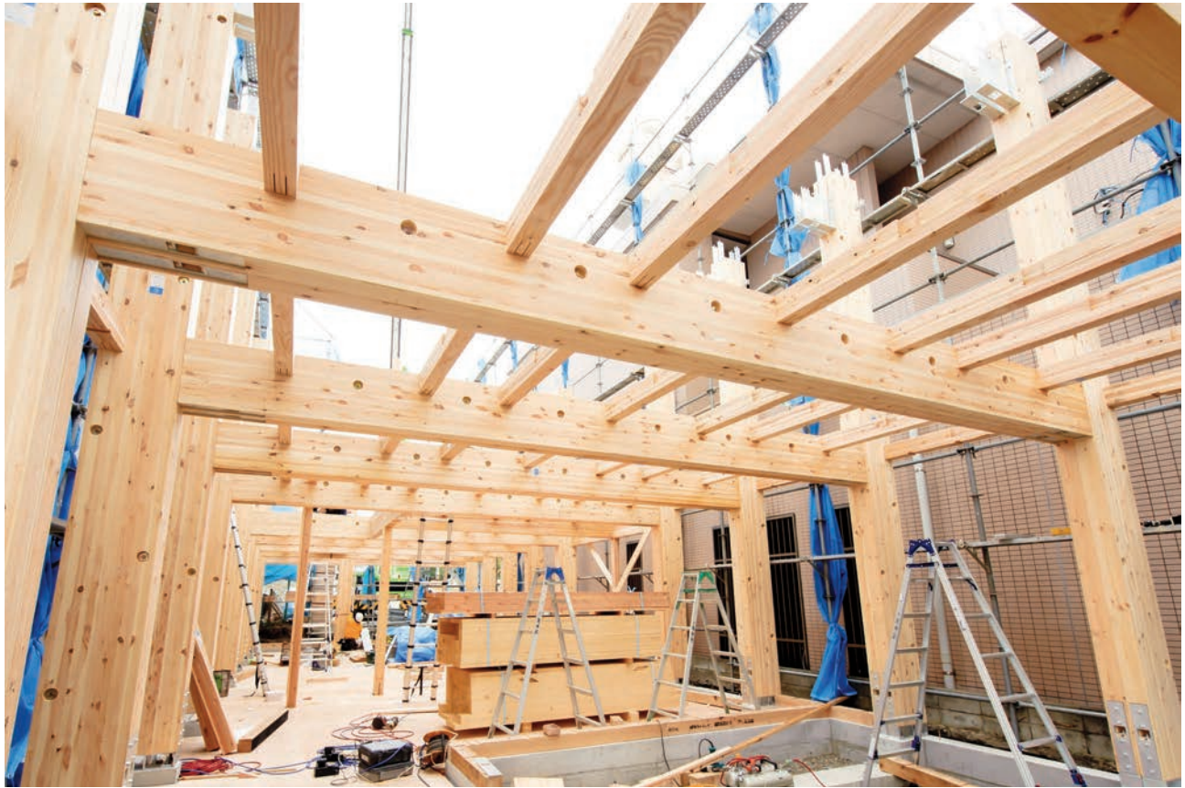
木造ラーメン構造の施工状況
