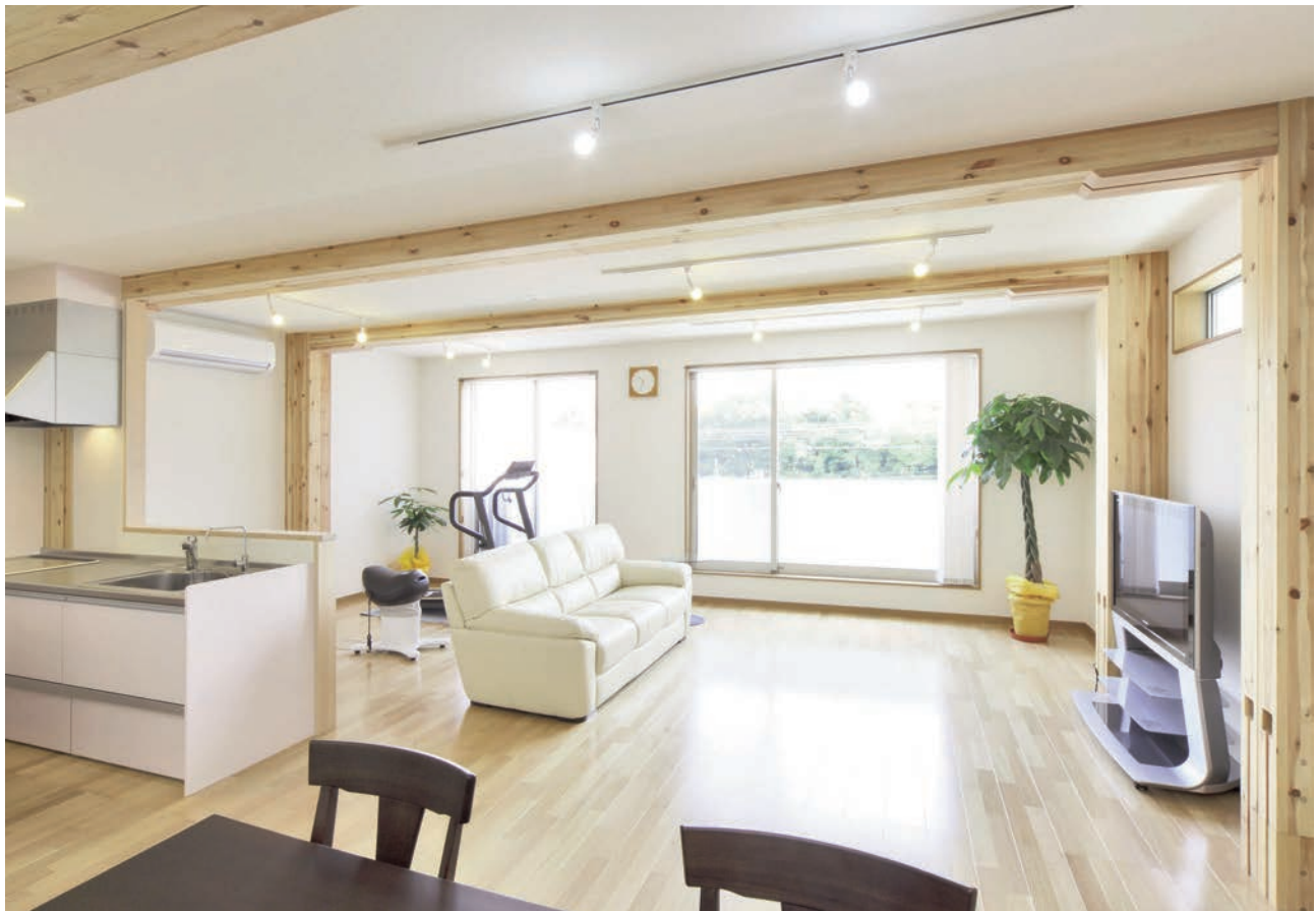
木造ラーメン構造の柱、梁があらわしの3階ショールーム。内部は各フロアーとも間仕切りなしの大空間
