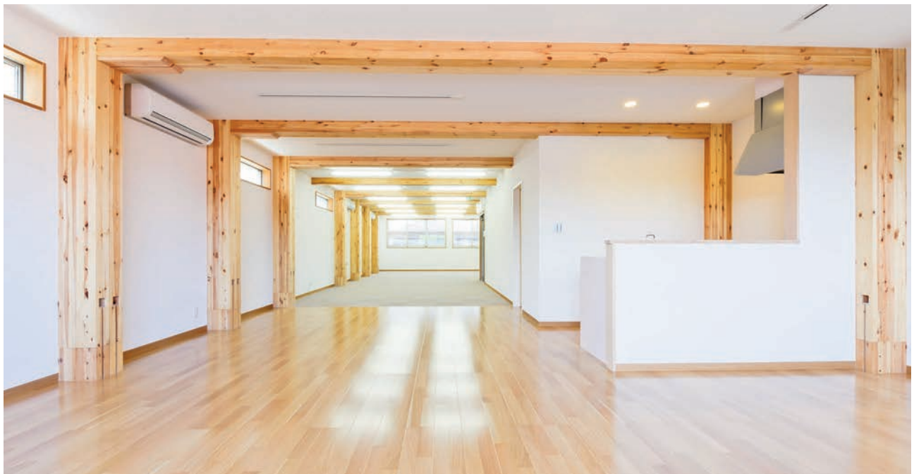
木造ラーメン構造の屋内。間口6m、65畳の大空間
